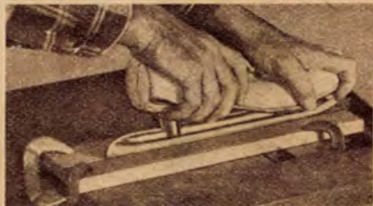
A két vezetőléc közötti hornyban még a műkorcsolya is jól élézhető
